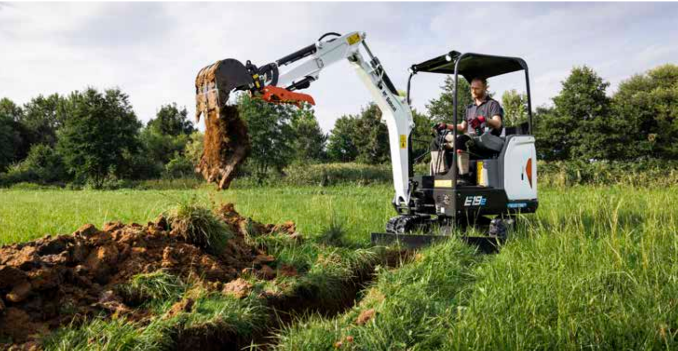
Creusement de tranchée avec l'E19e
