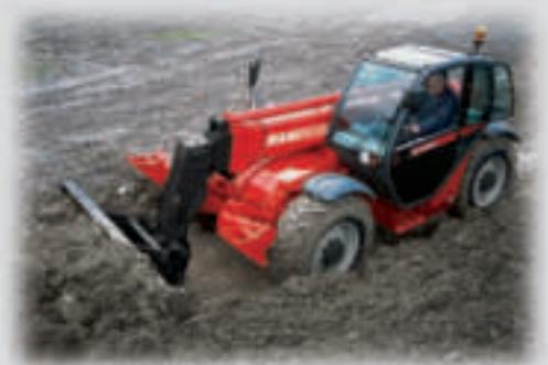
TERRASSEMENT : Levée/Descente + Cavage déversement
